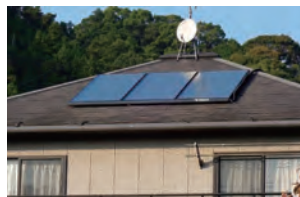
スレート屋根 - 固定線施工 【ESC-T1020J×3枚】
