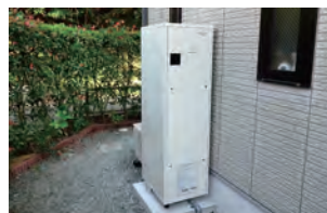
貯湯槽 - エコソーラーⅡ 【貯湯槽 200ℓ】
