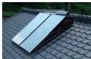
日本瓦 - 固定線施工 【SP-W420T】
