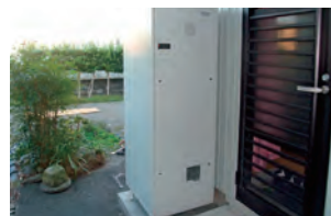
貯湯槽 - エコソーラーⅡ 【貯湯槽 300ℓ】
