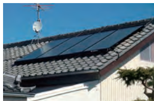
日本瓦 - 固定線施工 【ESC-T1020J×4枚】
