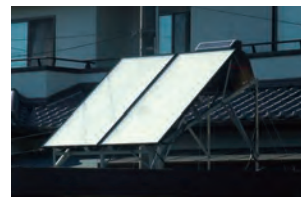
陸屋根 - 架台施工 【SP-W420T】
